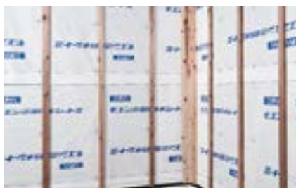
1. Монтаж мембраны и подсистемы
