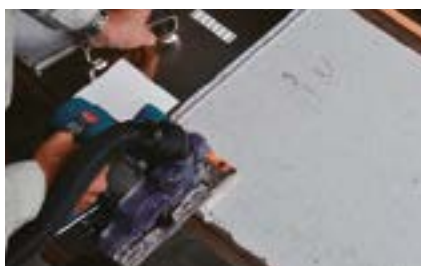
3. Резка панелей
