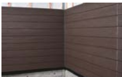
5. Монтаж панелей снизу вверх
