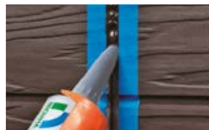
6. Герметизация швов вокруг проемов
